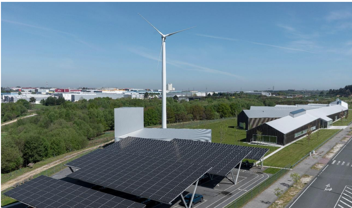
Instalación Fotovoltáica en el CIne, Centro de Innovación de Norvento Enerxía en Lugo
