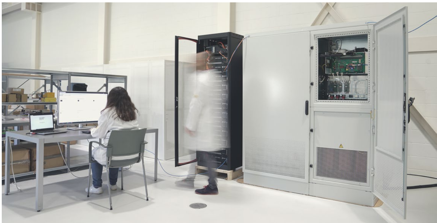
Norvento Gridmaster Converter (nGM) durante unas pruebas de integración en el laboratorio de Norvento Enerxía
