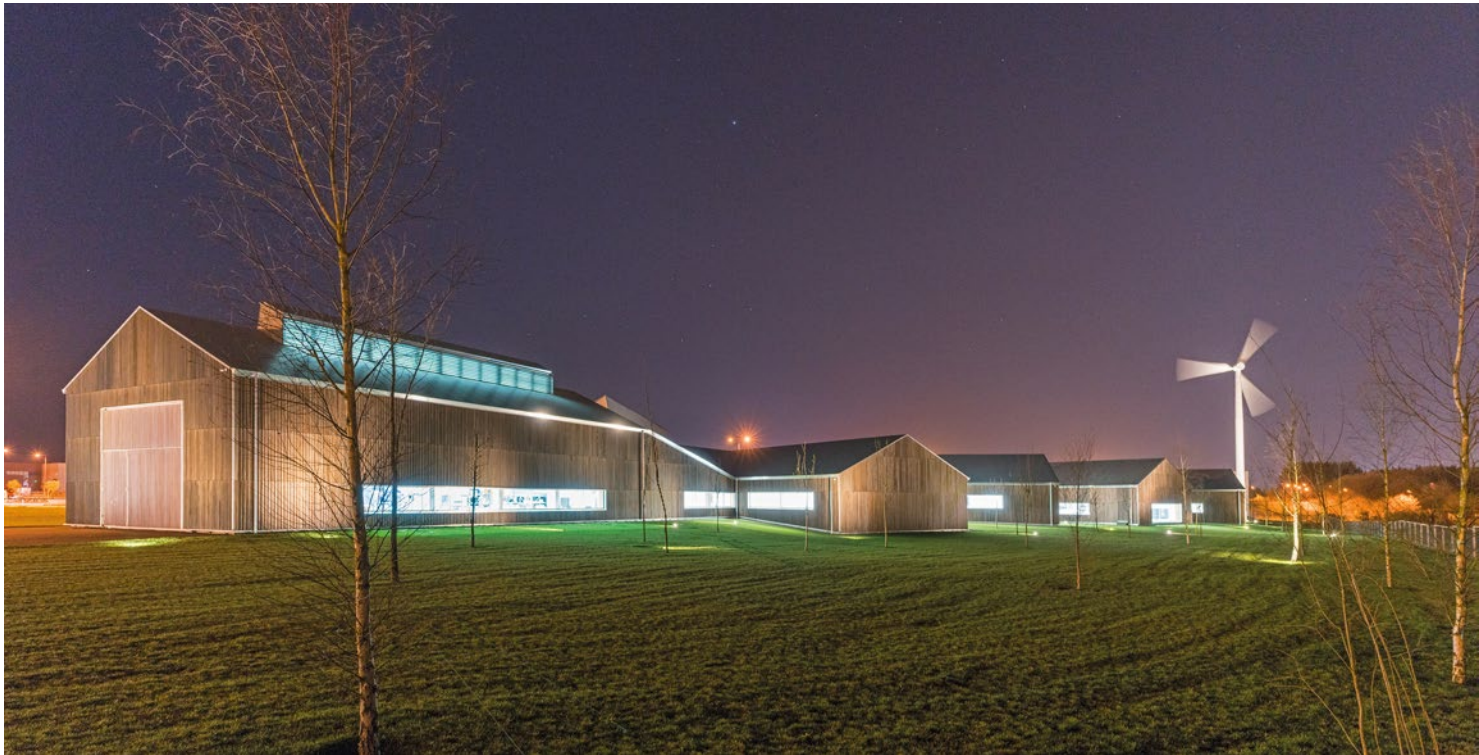
Centro de Investigación Norvento Enerxía (CIne)
